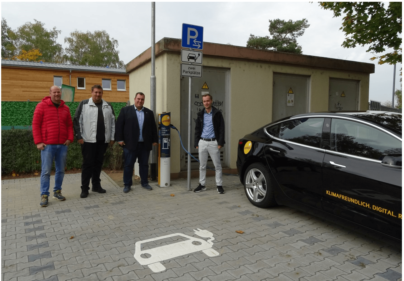
Bild: v.l.n.r. Jens Kretzschmar (Eigenbetrieb), Thorsten Zeizinger (Tiefbau), Bürgermeister Frank Simon, Tim Tolksdorf (Entega AG)
