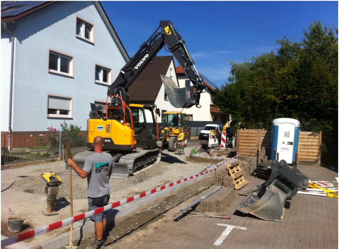
Es wurde ein neuer Straßenunterbau und die Verlängerung der Ablaufrinne mit einem neuen Sinkkasten hergestellt, um die Asphaltfläche fachgerecht zu entwässern. Im Anschluss daran wurde eine bituminöse Tragschicht eingebaut, welche dann später die Fahrbahndecke tragen wird, sodass die Straße sehr zeitnah wieder für den Verkehr freigegeben werden kann.
